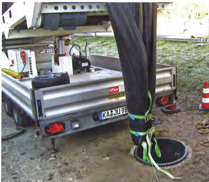
Die schwarzen Kapillarmatten des Abwasserwärmetauschers werden in die beiden Endschächte am jeweils äußeren Rand des Grundstücks eingezogen und danach miteinander verbunden.
