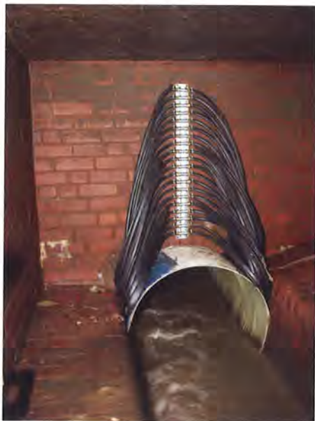
Blick auf die Kapillarstränge im Endschacht.
