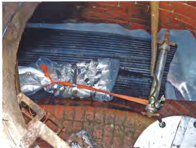
Einzug des Schutzliners in den Abwasserkanal.
