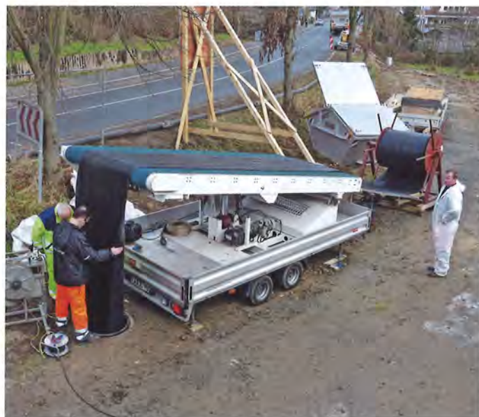
Die schwarzen Kapillarmatten des Abwasserwärmetauschers werden in die beiden Endschächte am jeweils äußeren Rand des Grundstücks eingezogen und danach miteinander verbunden.
