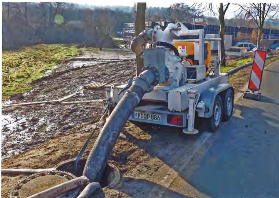
Während der Einbauarbeiten für den Wärmetauscher war eine umfangreiche Wasserhaltung erforderlich.
