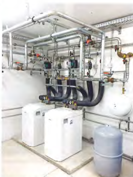
Anlageninstallation der Wärmepumpen und der Leitungen in der Heizzentrale im Untergeschoss des Gebäudes.
