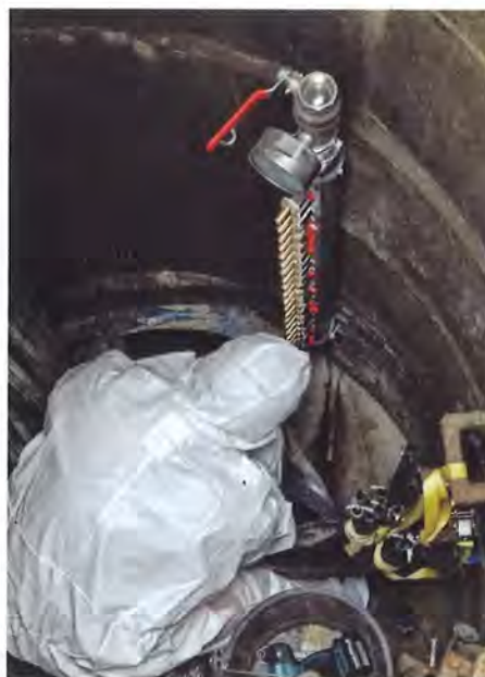
Die Kapillarstränge werden montiert.
