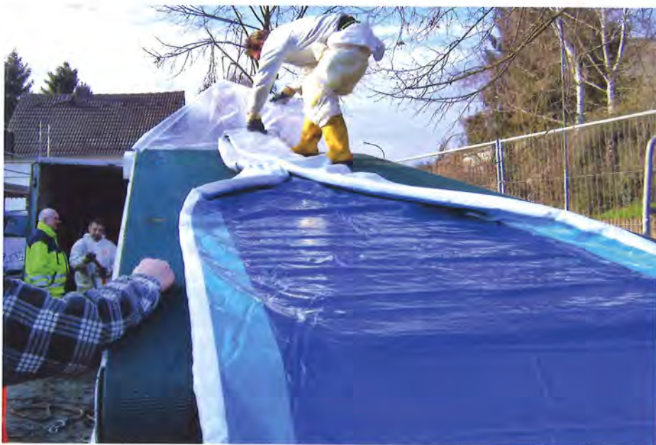
Schutzliner von Brandenburger zur Fixierung und zum Schutz der Wärmetauschermatte.
