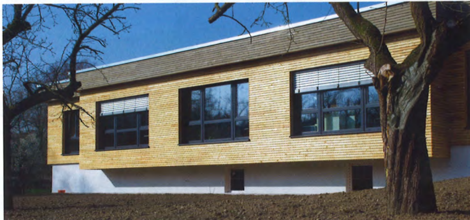
Im März 2014 konnte das Ingenieurbüro Golükes Ingenieure in das nach modernstem ökologischem Standard errichtete neue Bürogebäude an der Rheinstraße in Mühlthal Nieder-Ramstadt einziehen.
